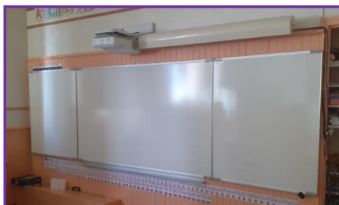
École : Réfection des peintures de la classe des grands Installation de tableaux Remplacement des blocs secours de la classe des grands et de l'entrée ainsi que des projecteurs extérieurs
