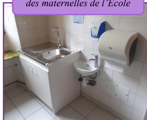
Aménagement des sanitaires des maternelles de l'École
