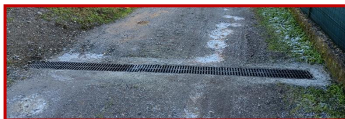
Installation de caniveaux sur la Route Sous Les Côtes
