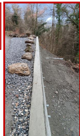
Confortement aval de la chaussée par cloutage et reconstitution d'une partie de l'accotement sur la Route de Notre Dame Des Millères
