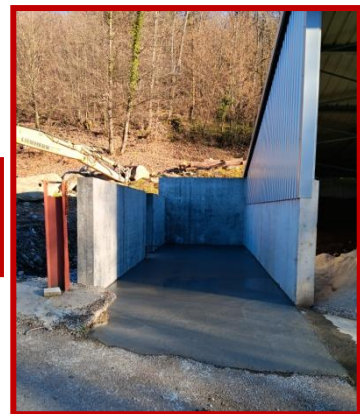
Création d'un abri à sel (maçonnerie) au Hangar Communal
