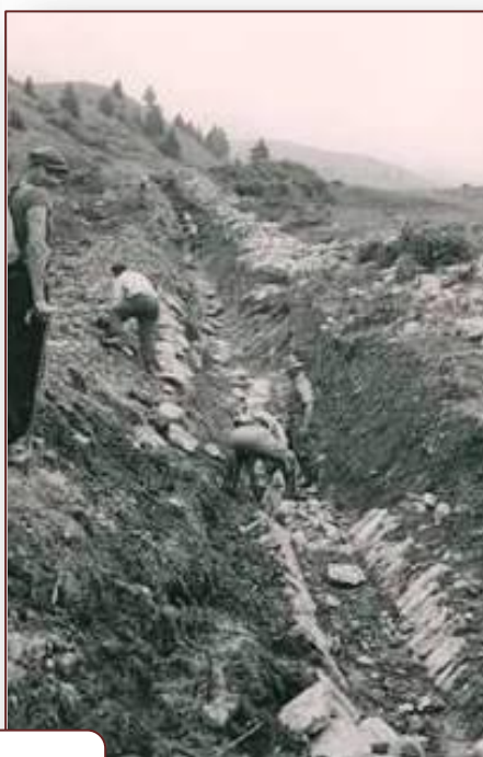
Drain BZ de La Pointière en construction Domaine de l'Hermettaz
