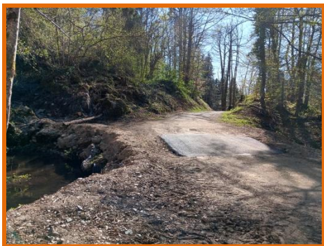
Installation d'une nouvelle buse sur la Route du Beillut
