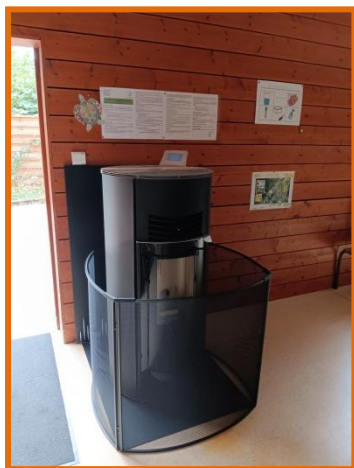
Installation de poêles à granulés dans l'École et dans la Salle Communale
