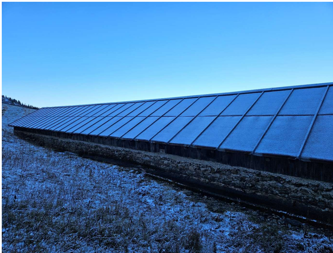
(1) Halles de 300 m 2 avec plancher (50 mètres de long) Parcelle 0B 366
