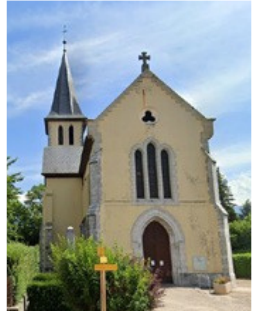
Église de Frontenex avant le séisme du 12 mars 2022
